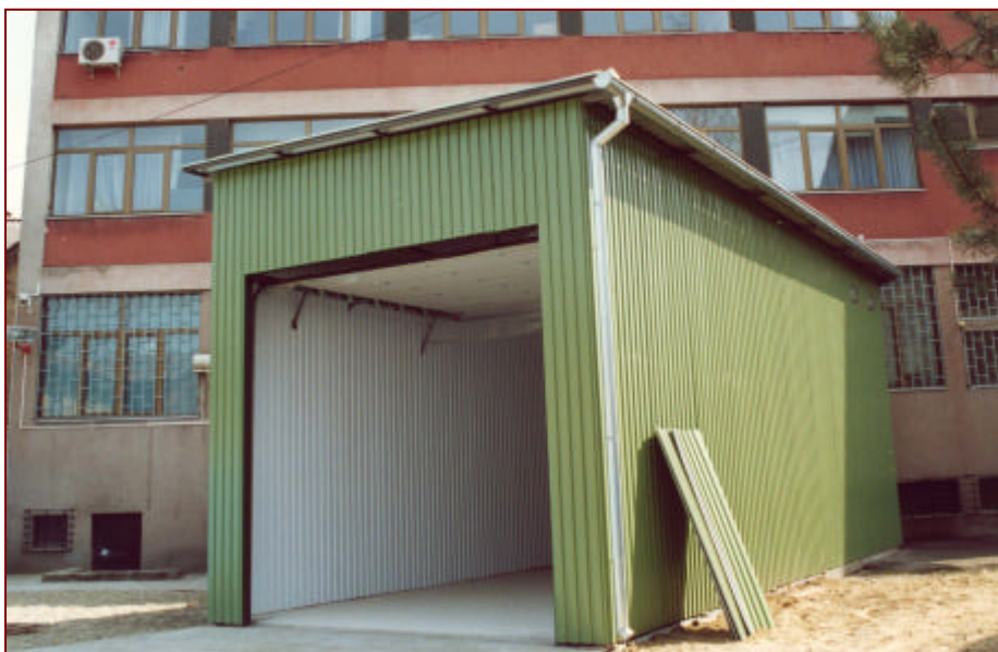
Nova montažna garaža u Filijali Brčko
